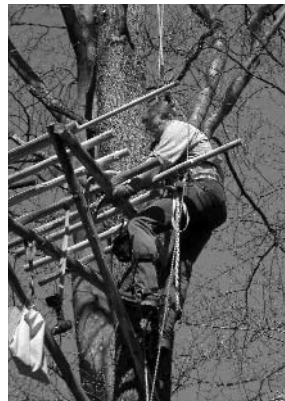
Das Grundgerüst der Nisthilfe aus Douglasienholz in ca. 15 m Höhe steht / Foto: Schepp
